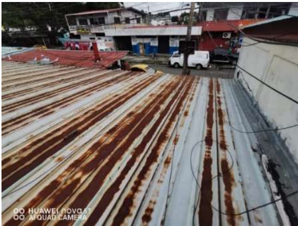
Cambio de techo en Silos Panamá.
