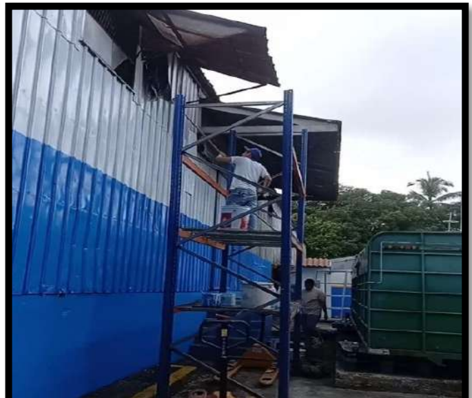
Pintura de Silos Panamá
